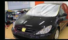
下地処理用のコンパウンドがゴムバーツなどに付着するのを防止します。
